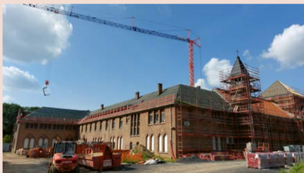
Le couvent pendant la rénovation
