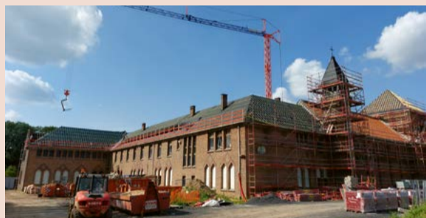
Het klooster tijdens de renovatiewerken
