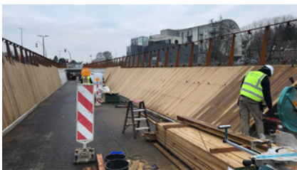
Fietstunnel F202, Kraainem & Zaventem
